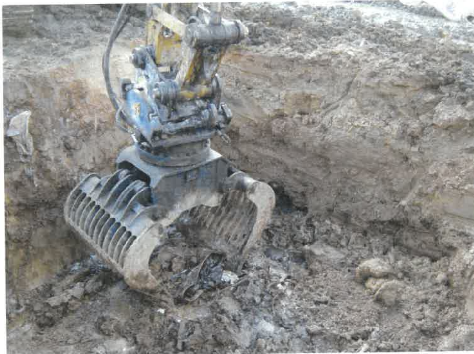
Photographie 31 : récupération des déchets à la pince multidirectionnelle
