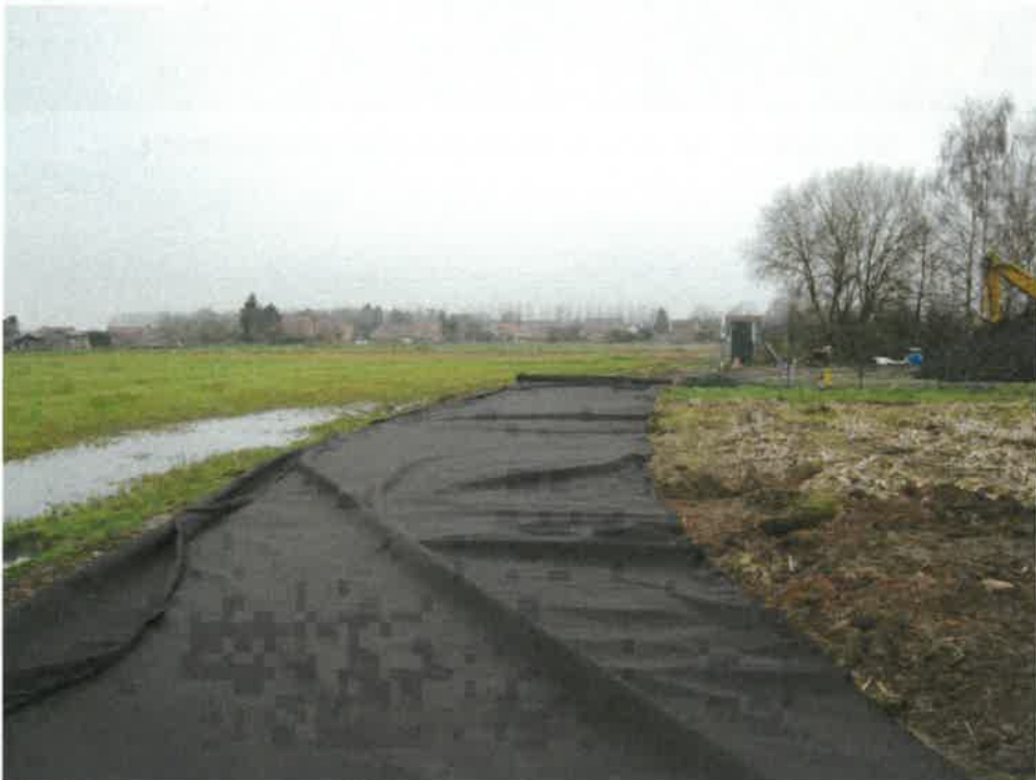
Photographie 47 : préparation de la route d'accès pour semi-remorque - installation d'un géotextile
