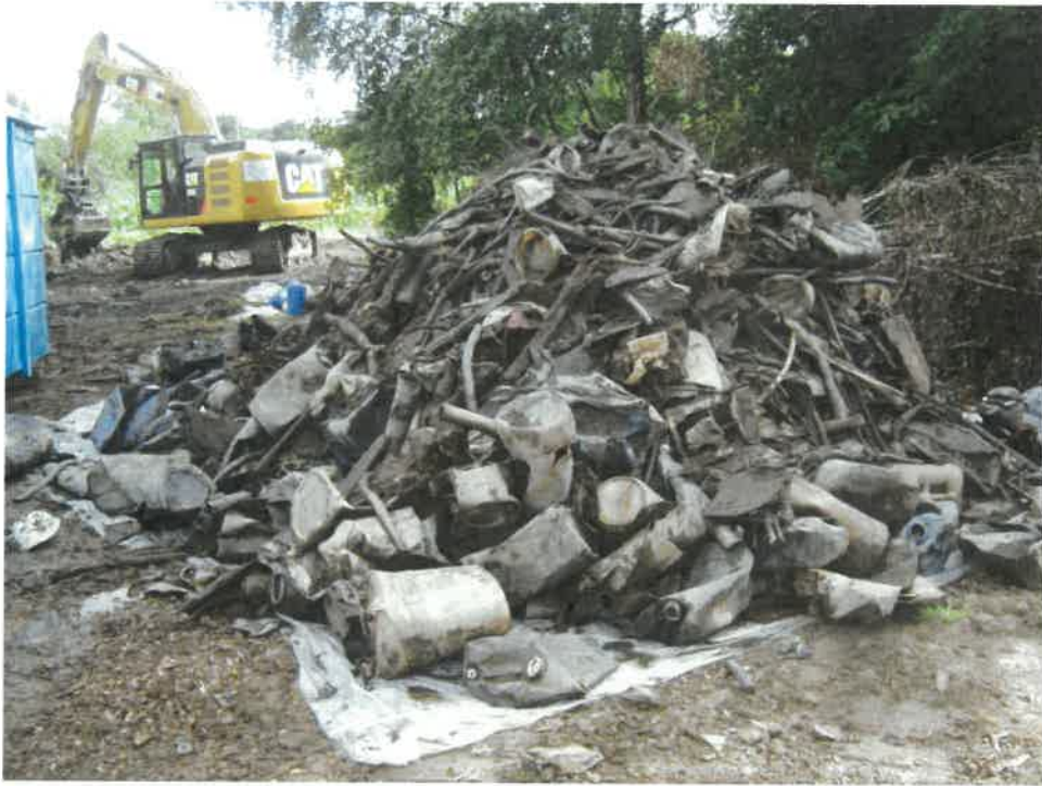
Photographie 41 : tri des matériaux - fûts plastiques en cours de tri
