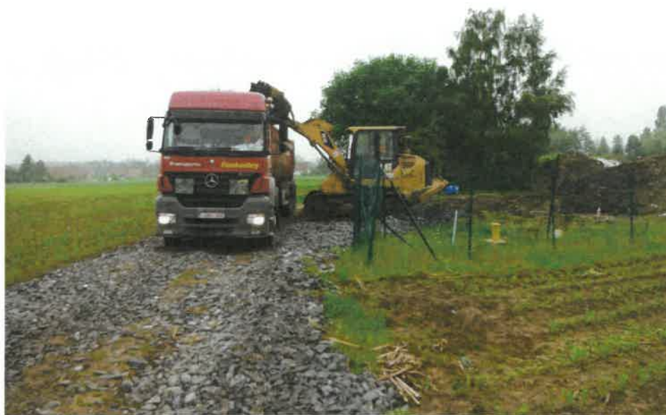
Photographie 54 : chargement des camions au chargeur sur chenille
