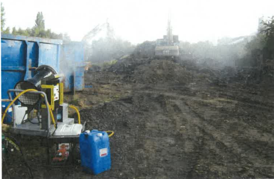
Photographie 34 : opération de pré-tri au godet dépauteur et de tri à la pince mécanique multidirectionnelle
