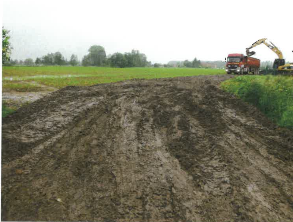
Photographie 52 : ornière dans la rampe d'accès due au passage répété des semi-remorques
