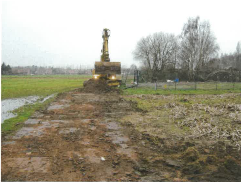
Photographie 46 : préparation de la route d'accès pour semi-remorque - raclage de la terre humide
