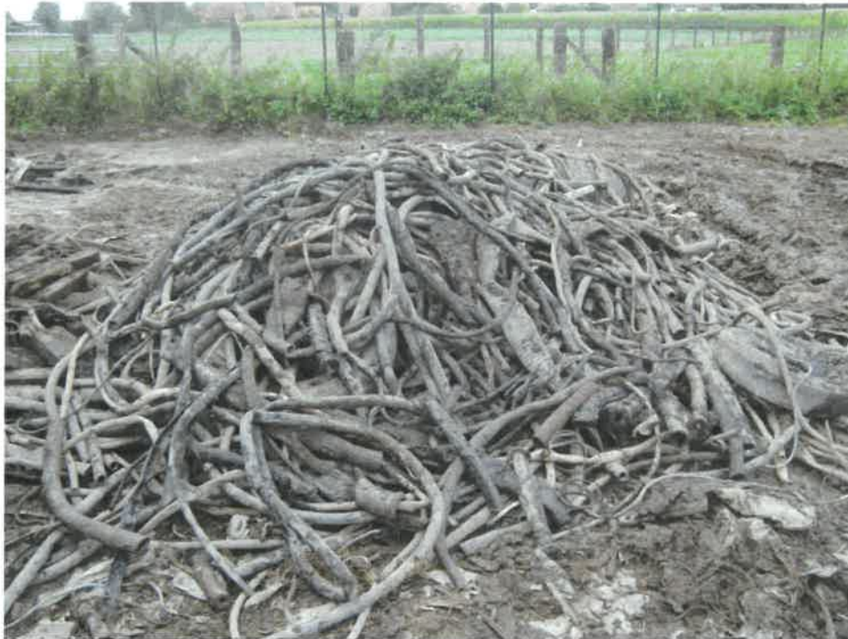
Photographie 39 : tri des matériaux avant évacuation - tuyaux caoutchouc
