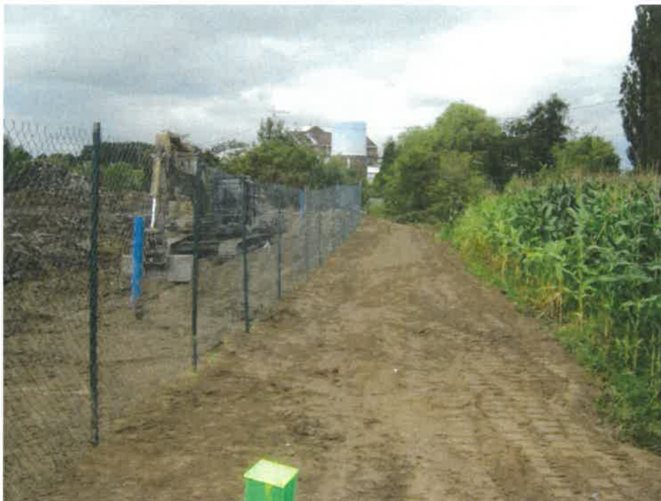
Photographie 42 : remblaiement de la zone C avec des terres propres
