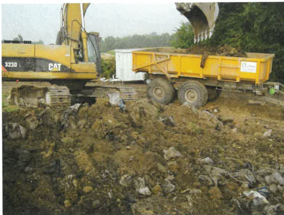
Photographie 18 : chargement du tracto-benne par maille de même catégorie
