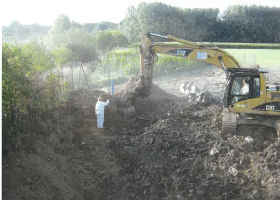
Photographie 36 : tri à l'avancement avec godet décapeur
