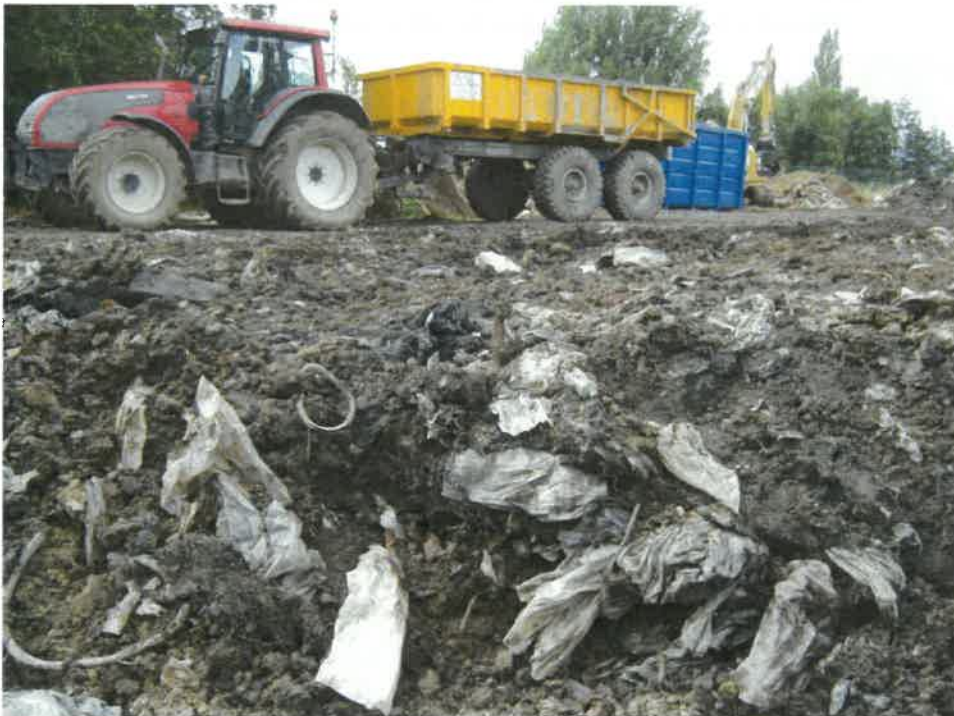
Photographie 17 : front d'excavation et tracto-benne
