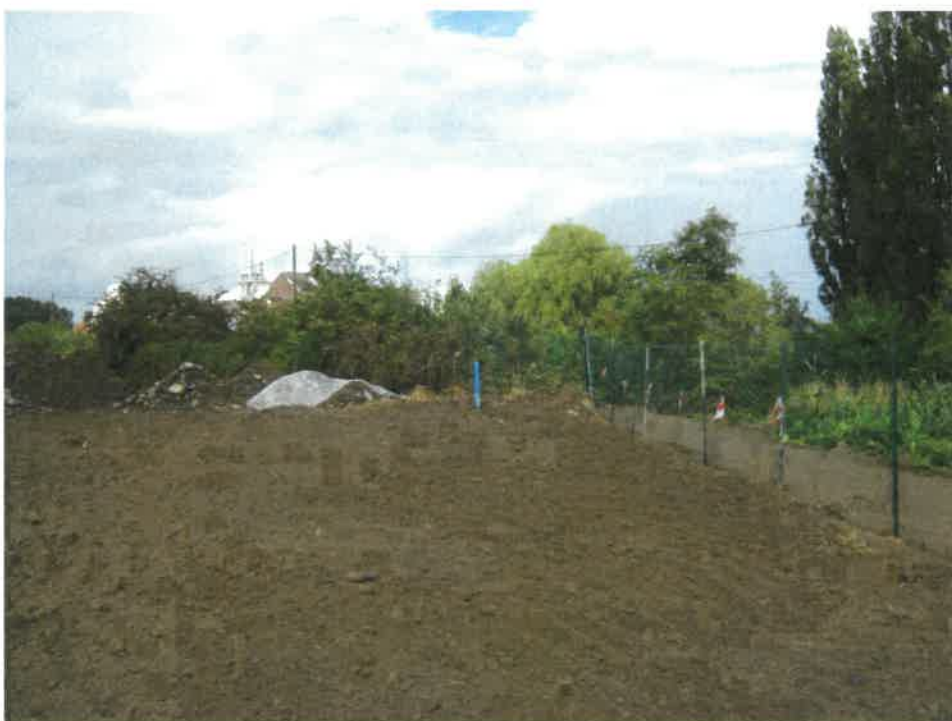
Photographie 43 : remblaiement de la zone A avec des terres propres
