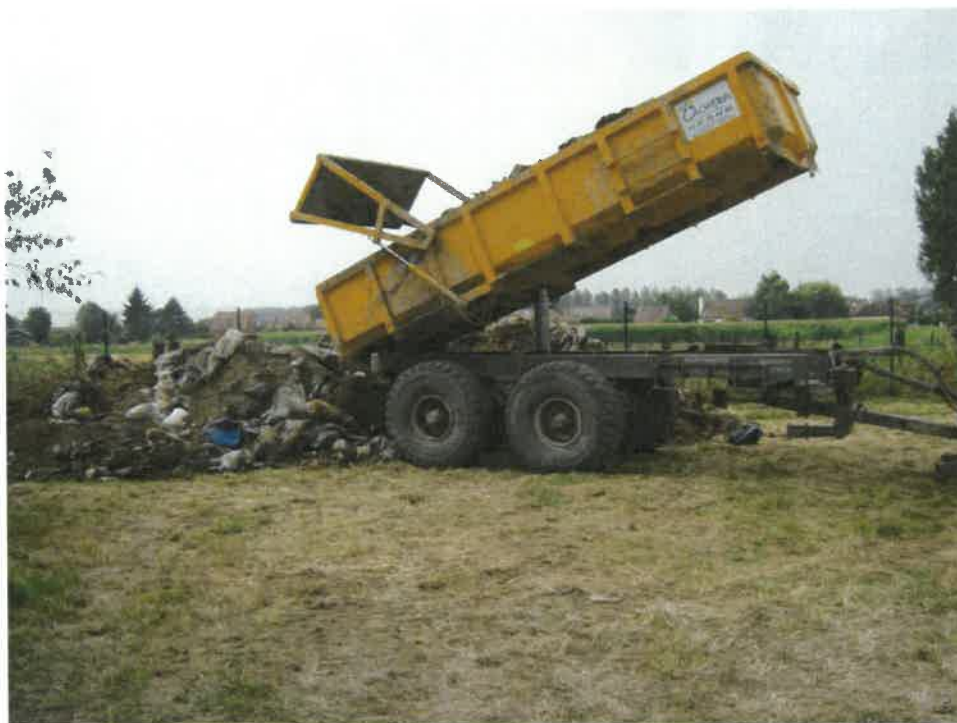
Photographie 19: déplacement des terres excavées par tracto-benne
