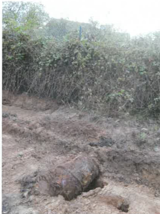
Photographie 28 : fût métallique partiellement enterré avant extraction
