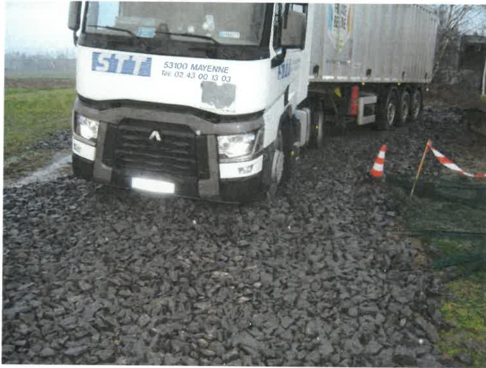
Photographie 48 : problème de circulation de semi-remorques chargées (roue dans une ornière)
