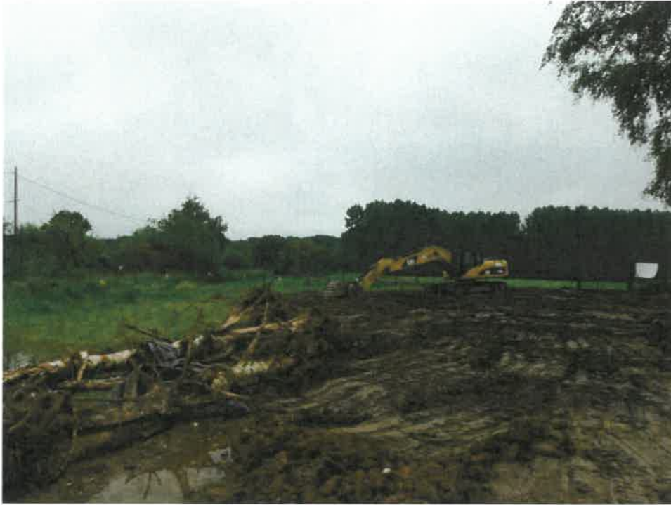
Photographie 56 : fermeture des zones de circulation à l'aide du godet de la pelle
