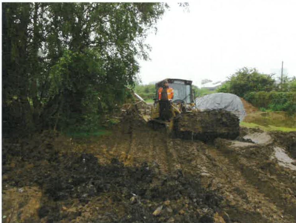
Photographie 51 : transfert des terres du site au chargeur sur chenille
