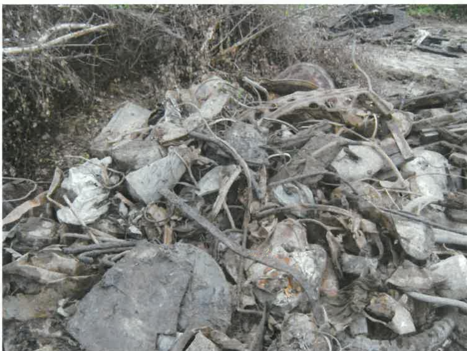
Photographie 38 : tri des matériaux avant évacuation - ferraille
