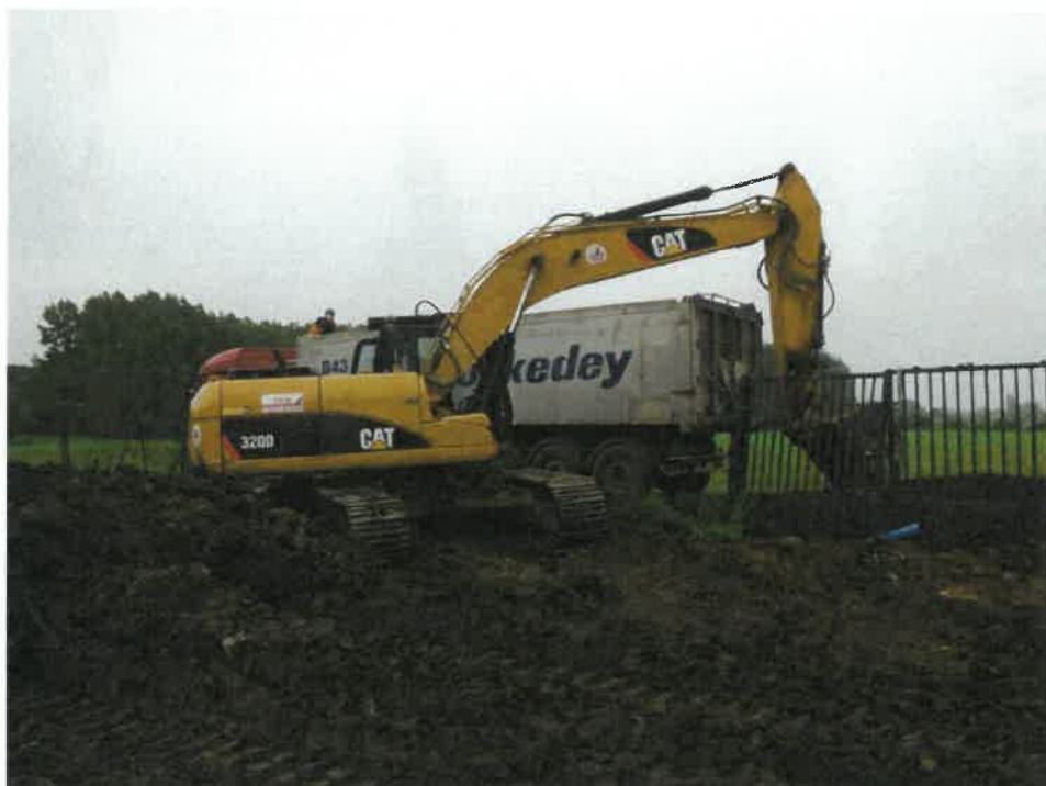
Photographie 55 : chargement des camions à la pelle 21 tonnes
