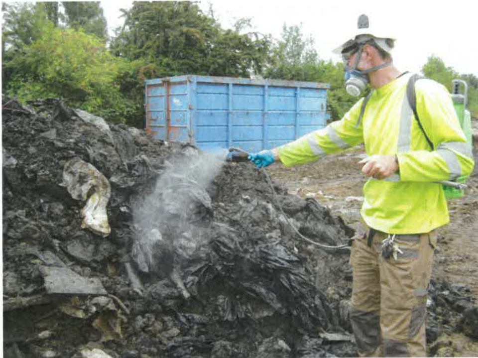
Photographie 22 : aspersion de produit fixateur d'odeur pour un stockage prolongé
