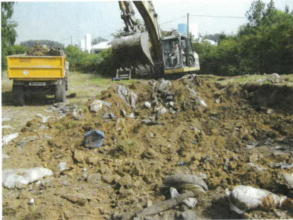
Photographie 14 : début de l'excavation - partie haute du massif de déchets
