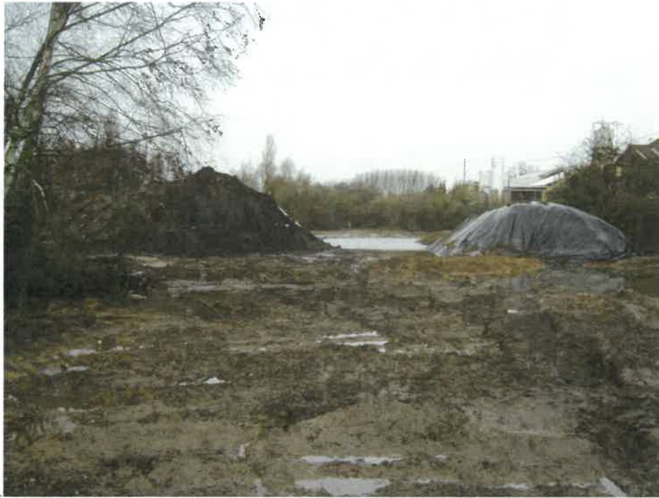
Photographie 50 : état du site le 16/12/2015 après circulation de la pelle durant 3 jours
