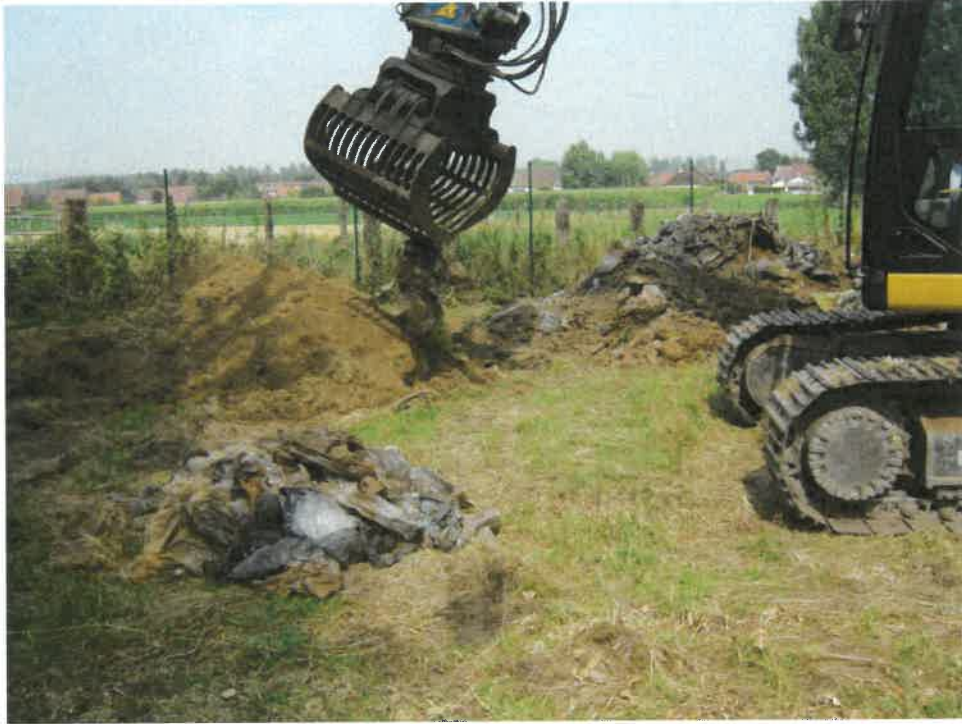
Photographie 33 : tri des déchets à la pince mécanique
