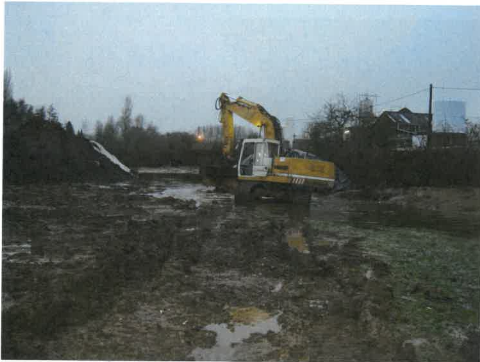
Photographie 49 : problème d'enlisement de la pelle
