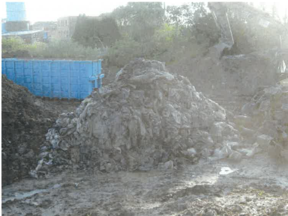
Photographie 37 : tri des matériaux avant évacuation - emballages plastiques souillés
